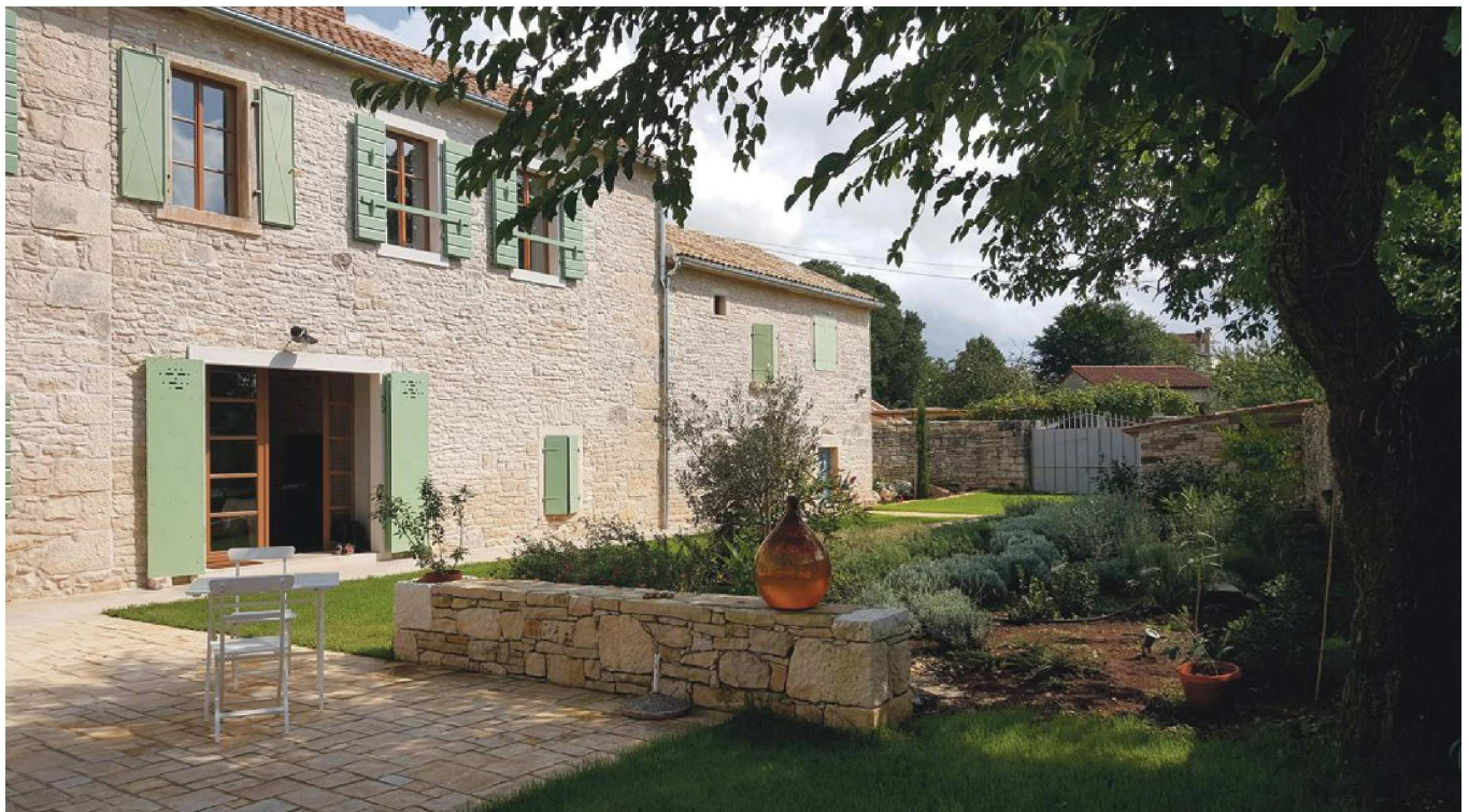
Fasada istrske hiše je po prenovi olupljena ometa.
